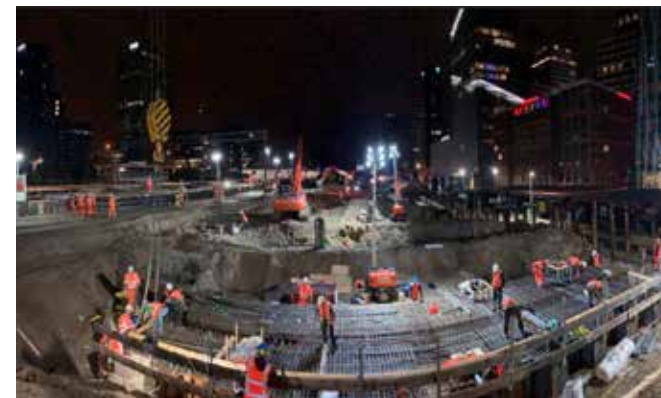
Diverse landmeetkundige werkzaamheden werden deze zomer op Zuidasdok uitgevoerd tijdens een buitendienststelling van 11 dagen.
